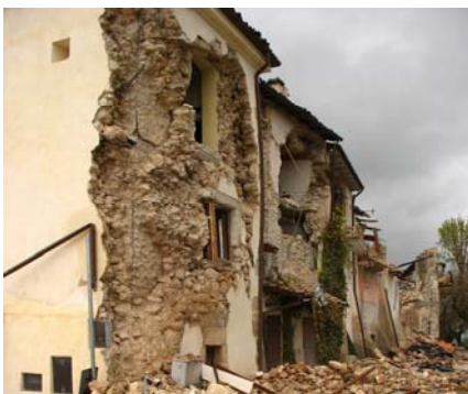
Foto: Arch. Fot. Vice Comm. Del. Beni Culturali - Sisma Abruzzo 2009
